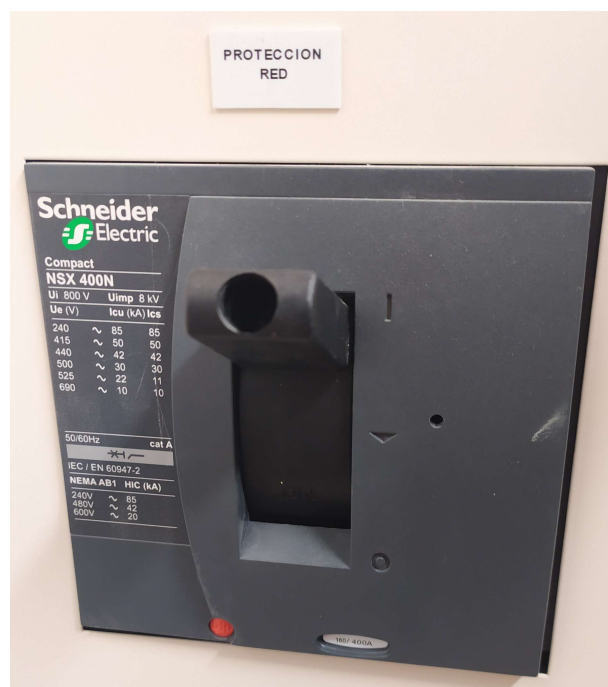
Figura 2. Interruptor general de 125A trifásico
