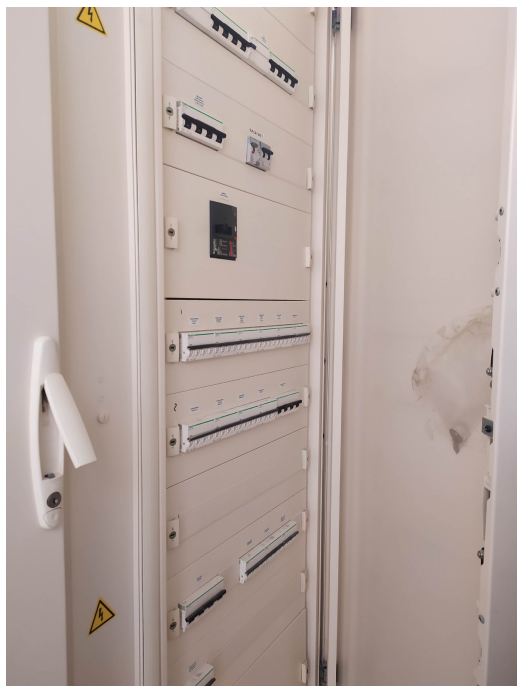
Figura 1. Cuadro de protecciones principal
