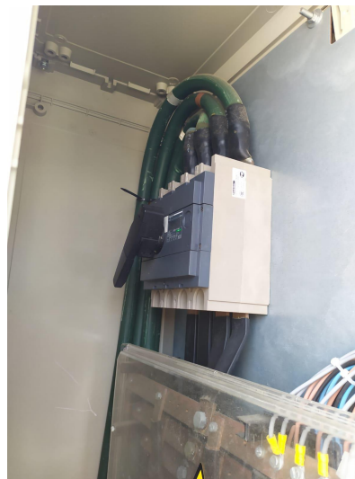
Figura 2. Interruptor principal subcuadro y embarrado
