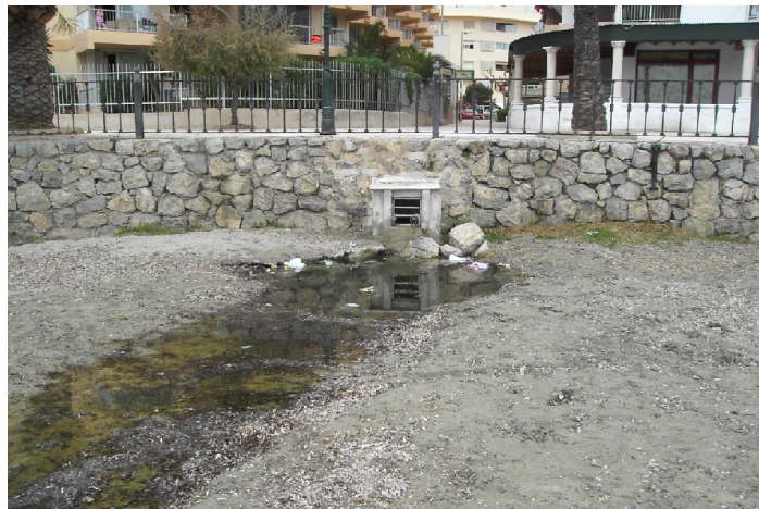
Fig.1. Salida de pluviales actual en la playa de Figueretas.
