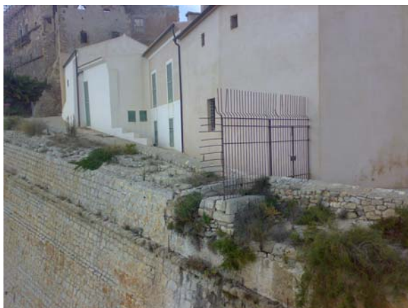
07. Vista del paramento entre baluartes y ubicación de puerta a reformar
