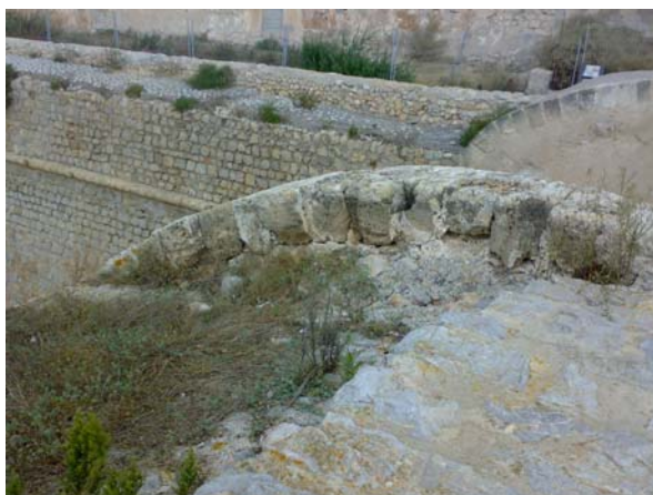
05. Vista de la casamata de San Bernardo
