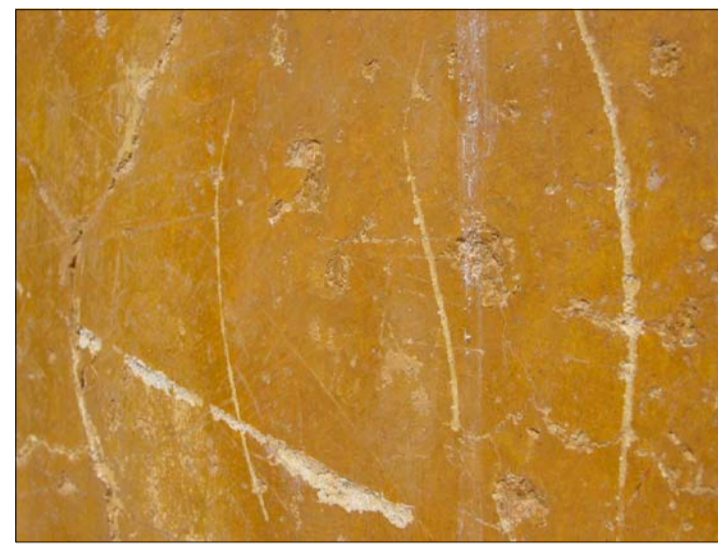
Detalle en el que se percibe el color original de los paños de fachada sur
