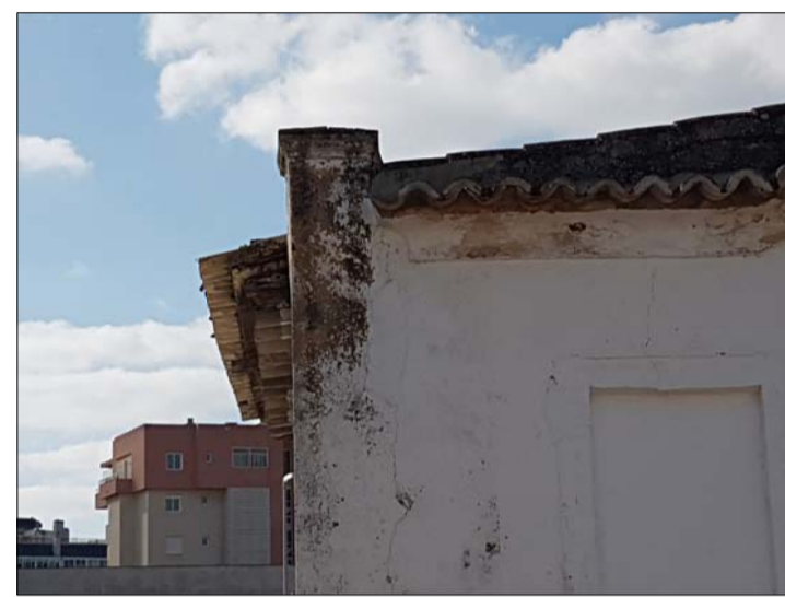
Detalle de la pilastra de esquina en fachada norte
